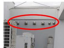
「局所換気」=フード(画像赤丸)などを設け、汚染された空気を拡散する前に排出するもの。ガス機器など熱機器の一酸化炭素・熱・蒸気を排気する。
