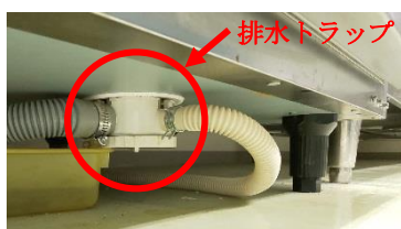
ベージュ色のホースが冷却器からのドレン。グレーのホースが排水口へ。 (写真はバットで受けています)
