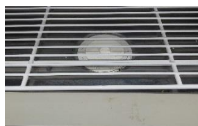
庫内下部を見たところ
